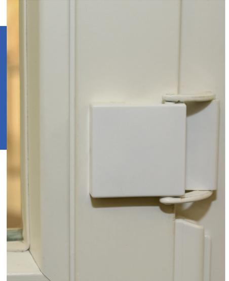
Scharniere und Angeln werden einbruchssicher verstärkt.
